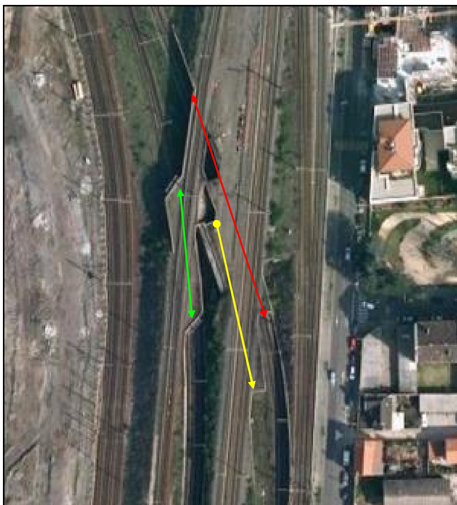
Vue aérienne des sauts de mouton de Mouche Sud Flèche verte, saut de mouton Mouche Sud 1 Flèche jaune, galerie borgne du saut de mouton Mouche Sud 2 Flèche rouge, galerie en service du saut de mouton Mouche Sud 2
