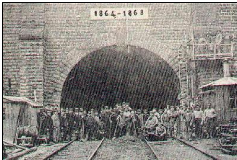
Les ouvriers vers la fin du chantier
