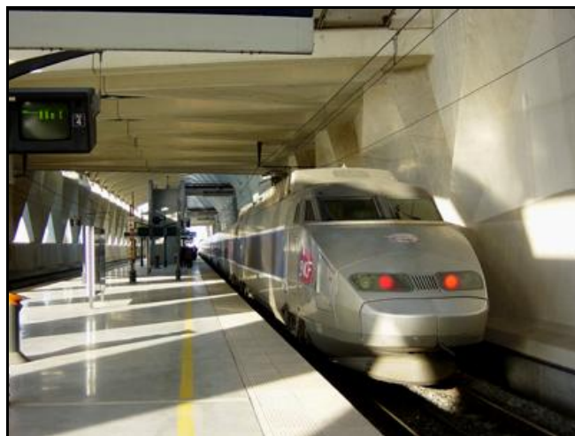
Vue des quais et voies latérales Sur la photo de droite, la cloison située à droite du TGV sépare celui-ci du faux tunnel central
