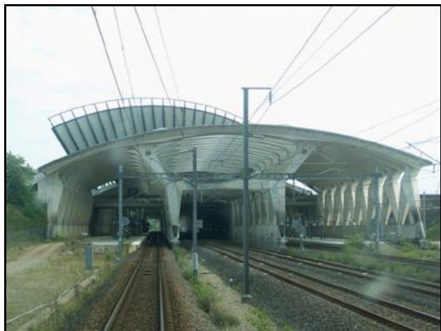
Ci-contre, entrée de la voie latérale est
