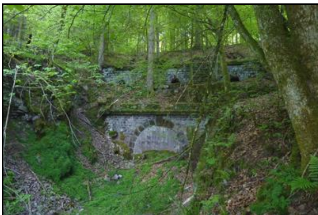
Les entrées des trois galeries de dynamitage au-dessus du fronton de sortie du tunnel
