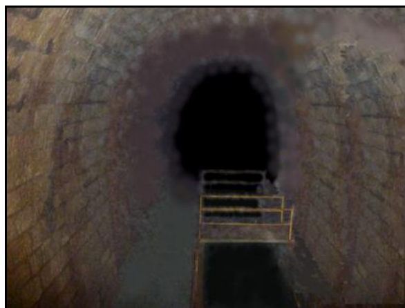
L'intérieur de la galerie et les aménagement de captage
