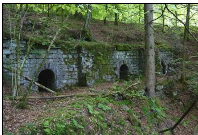
Les entrées des trois galeries de dynamitage au-dessus du fronton de sortie du tunnel
