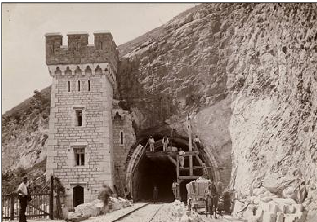
La ligne Culoz > Aix les Bains était primitivement à voie unique. Elle fut mise à double voie en 1901. La belle photo ci-dessus montre les travaux de reconstruction du fronton de sortie après élargissement du tunnel
