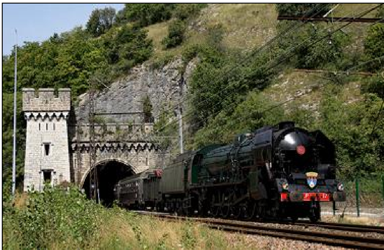
Et, ci-dessus et ci-dessous, la sortie avec sa tour carrée
