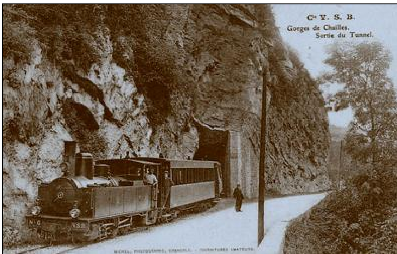
L'entrée du tunnel du temps du petit train
