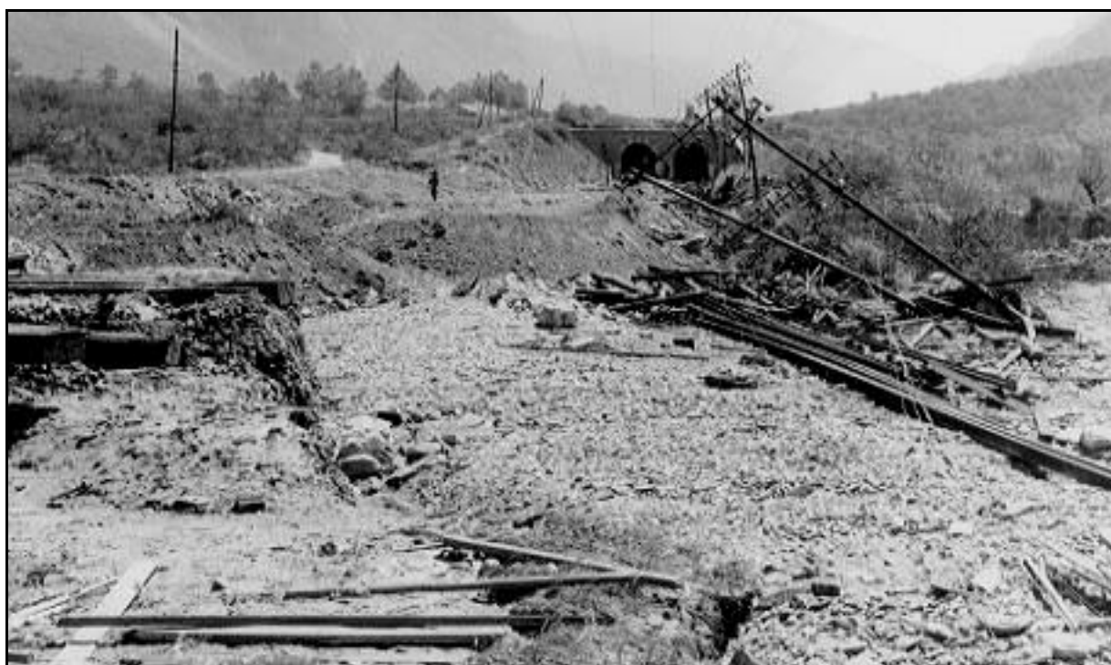
Les deux galeries de l'ensemble de Saint Julien suite à la crue du 14 juin 1957 L'entrée de la galerie Voie 1 est ici à gauche
