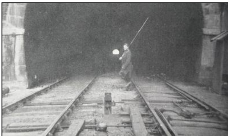
La garde au tunnel
