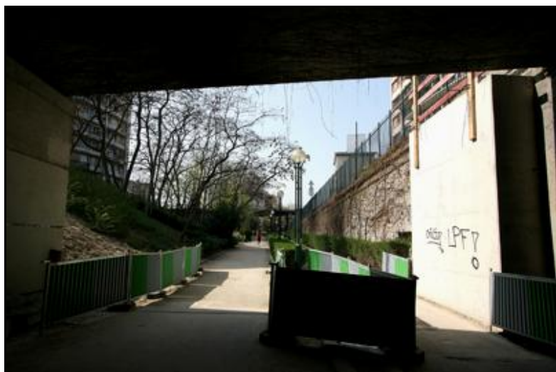
Ci-contre, l'entrée de la galerie Sout 1 vue de l'intérieur
