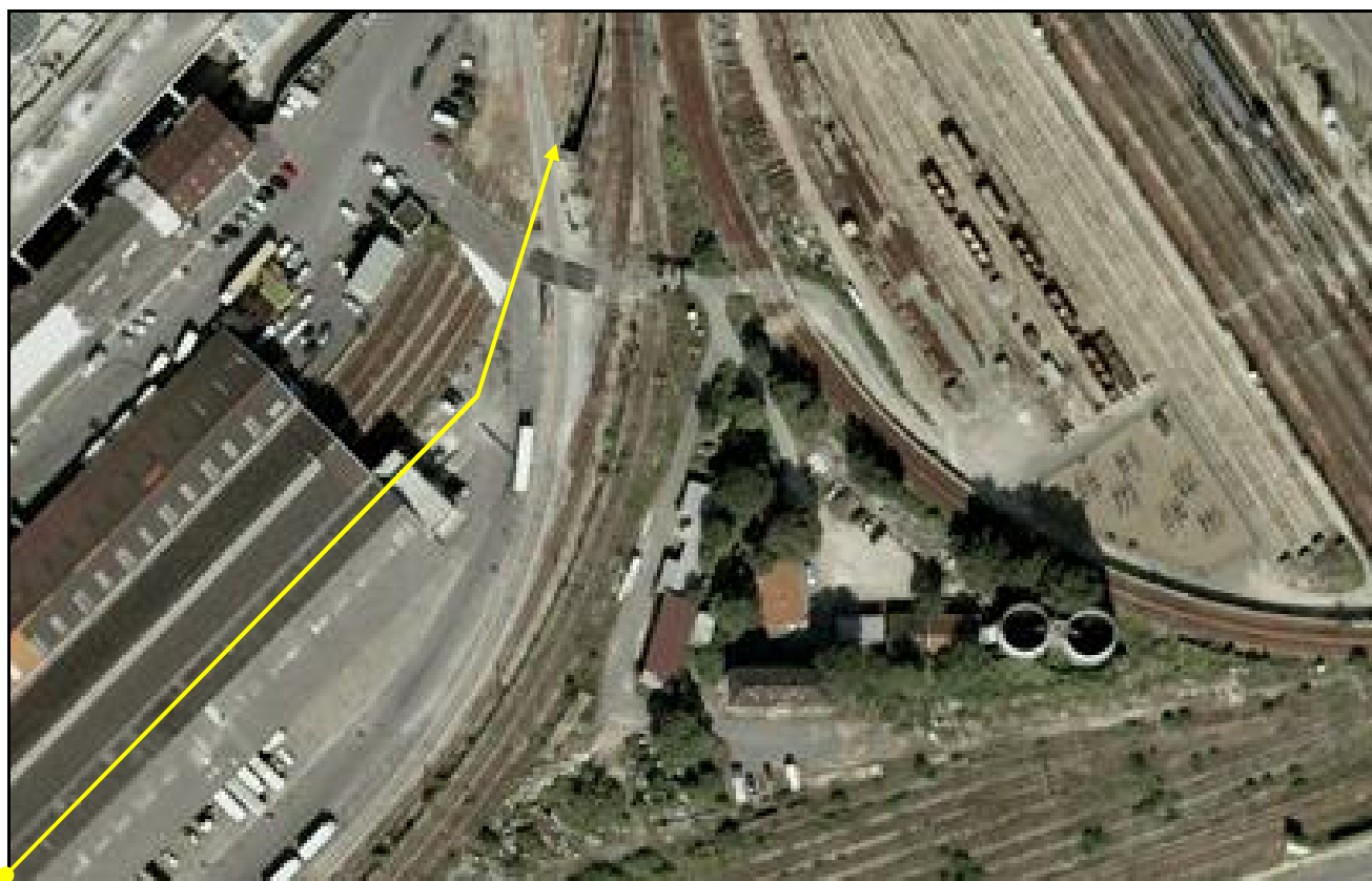
Vue aérienne de la rampe d'accès et de la gare marchandises de surface de la Râpée
