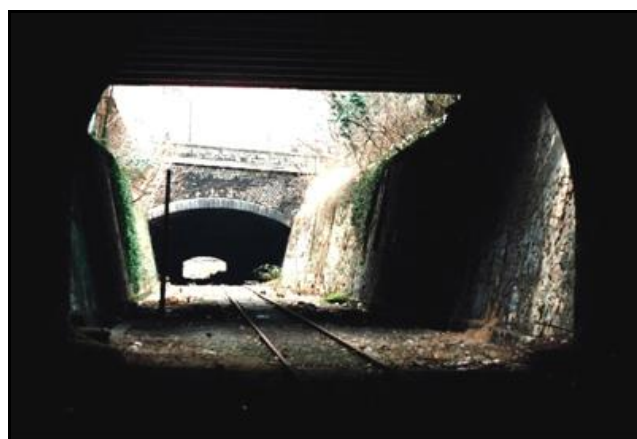
Sortie de la galerie de la Porte de Choisy vue depuis l'entrée de celle de la Porte d'Ivry
