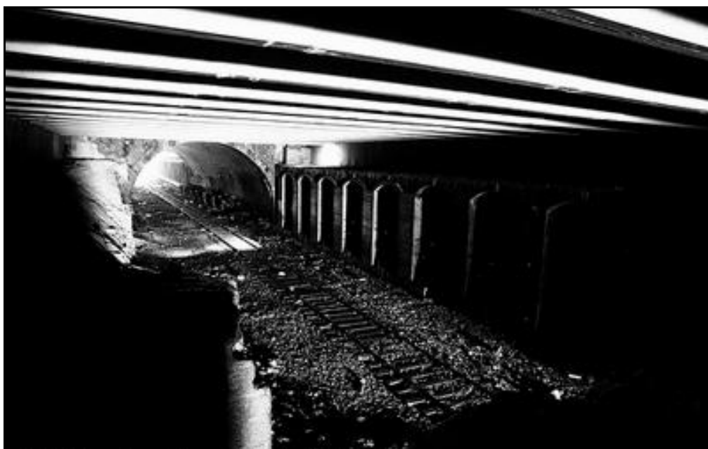
L'intérieur de la galerie
