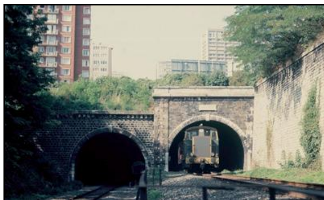
La sortie de la galerie d'Ivry est ici à gauche A droite, l'entrée de la galerie des Gobelins
