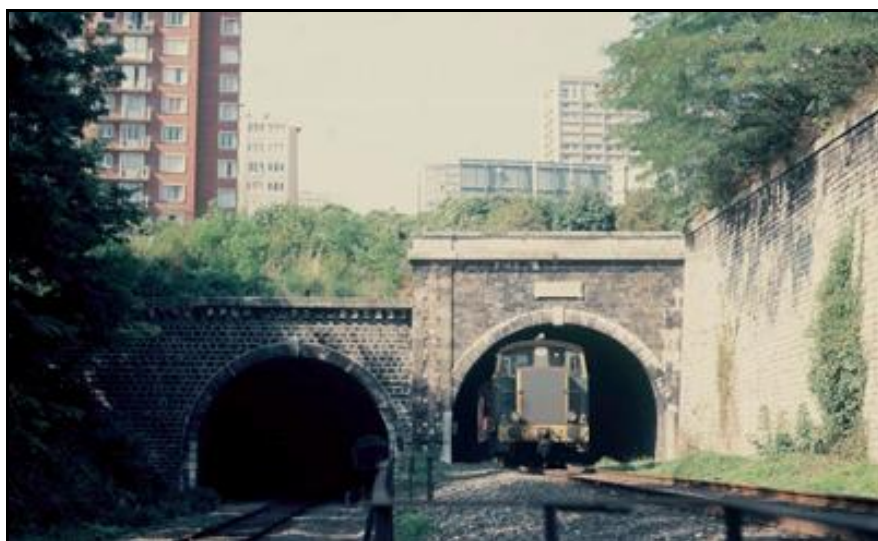
Ci-contre, l'entrée de la galerie des Gobelins à droite et la sortie de la galerie d'Ivry à gauche
