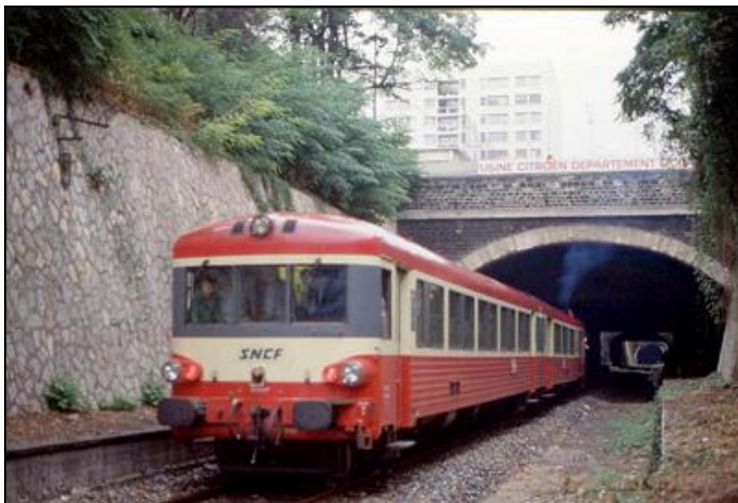
A l'entrée de la galerie, un des derniers trains ayant emprunté la petite ceinture
