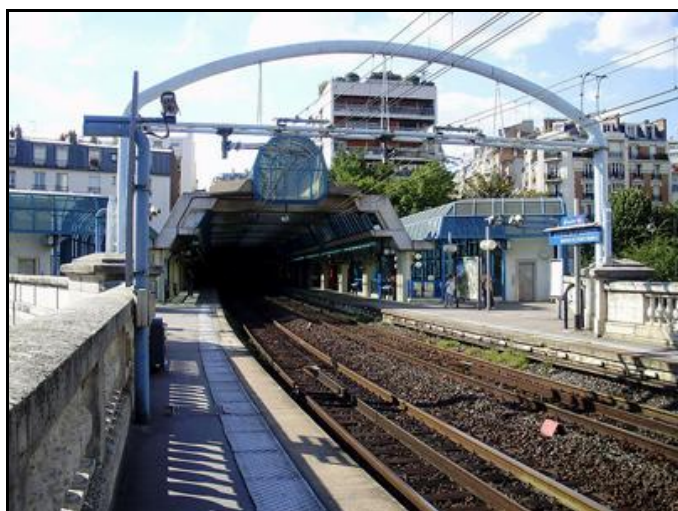
La station Kennedy qui constitue l'entrée de l'actuel tunnel de Boulainvilliers
