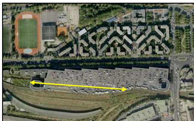
Vue aérienne du parking et de sa galerie
