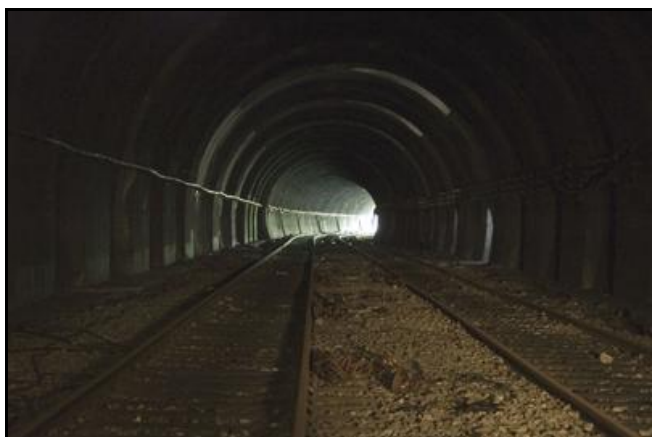
Le faux tunnel de liaison Les jours latéraux et dans la voûte sont dus aux cheminées d'aération
