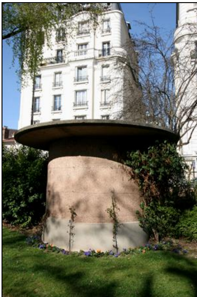
Ci-dessus et ci-dessous, le débouché des cheminées d'aération en surface, dans le parc du Sorbier
