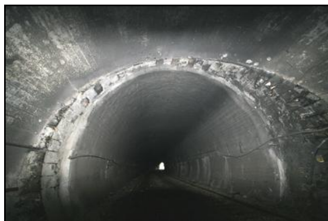
La fin du faux tunnel de liaison et le raccord avec l'ancien tunnel courbe du Sorbier dont une partie du fronton d'entrée est encore visible sur la photo de droite
