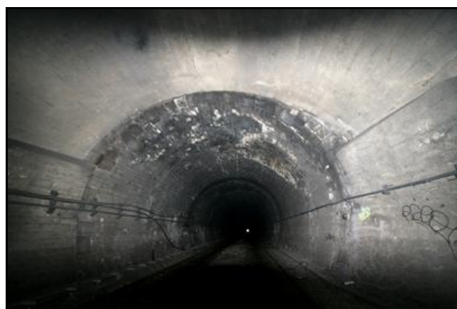
Le raccord entre le tunnel proprement dit en fond et le faux tunnel de liaison au premier plan
