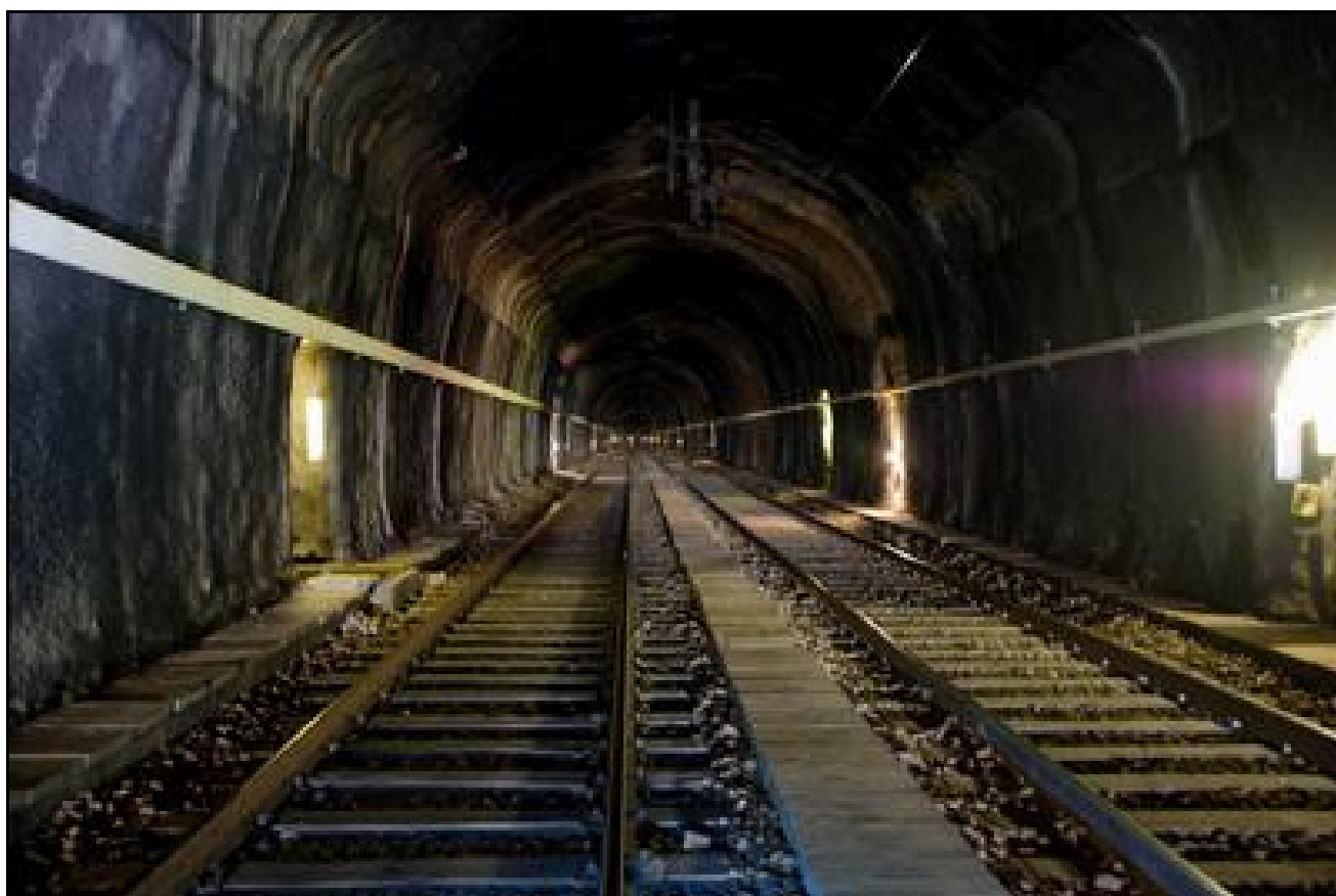
La belle galerie du tunnel de Sainte Catherine
