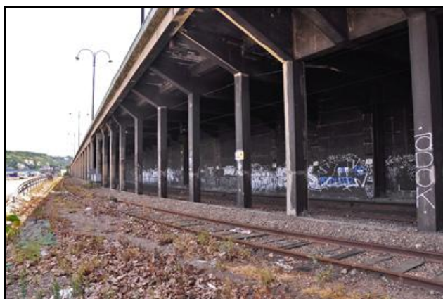
La galerie avec son côté gauche ajouré et son côté droit avec un piédroit plein
