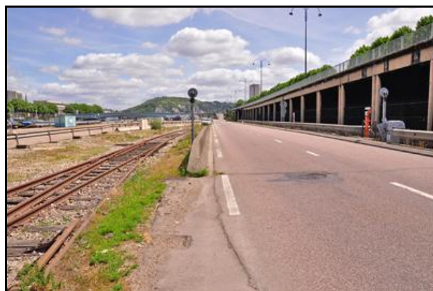
La galerie avec son côté gauche ajouré et son côté droit avec un piédroit plein
