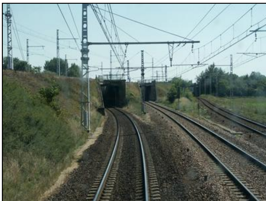
A gauche, l'entrée de la galerie de Moque Bouteille 1 En arrière à droite, l'entrée de la galerie de Moque Bouteille 3
