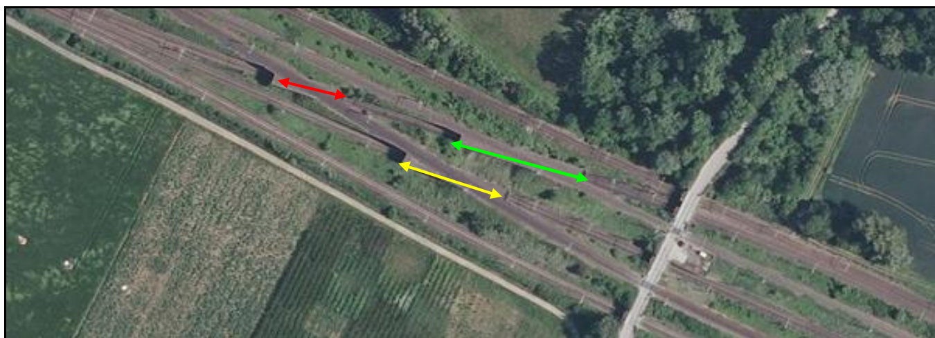
Vue aérienne de l'ensemble des trois galeries de Moque Bouteille
