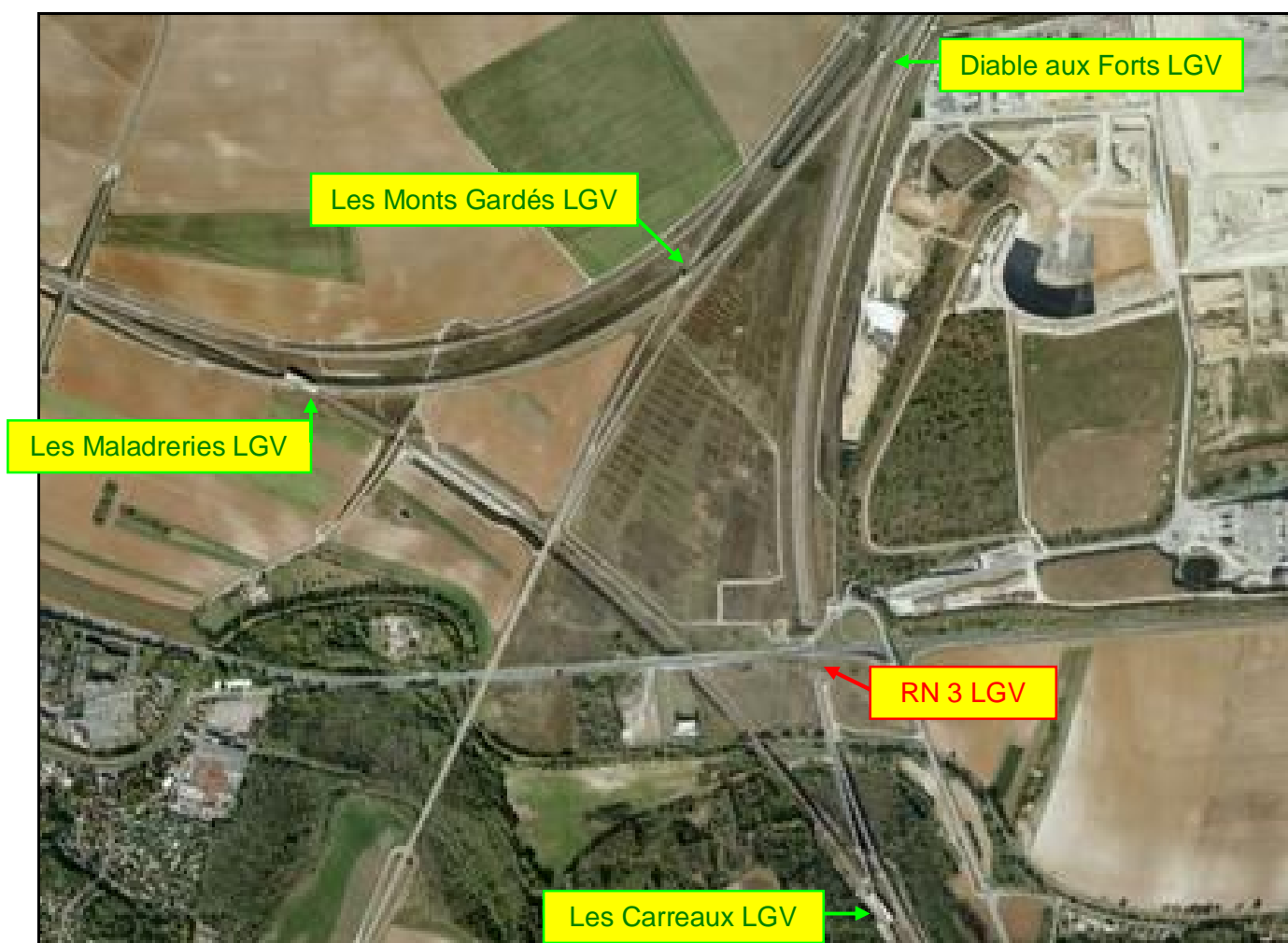
Vue aérienne globale du nœud LGV des Monts Gardés et de ses galeries
