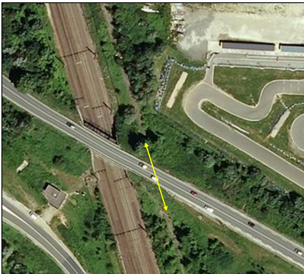
Vue aérienne de la galerie du Pont de Paris
