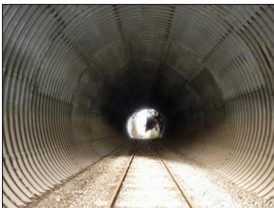
L'intérieur de la galerie
