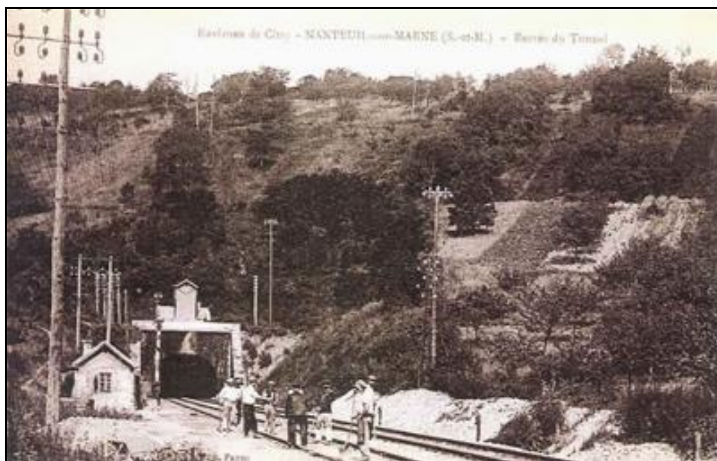
Une équipe de cantonniers de la voie en plein travail devant la sortie du tunnel
