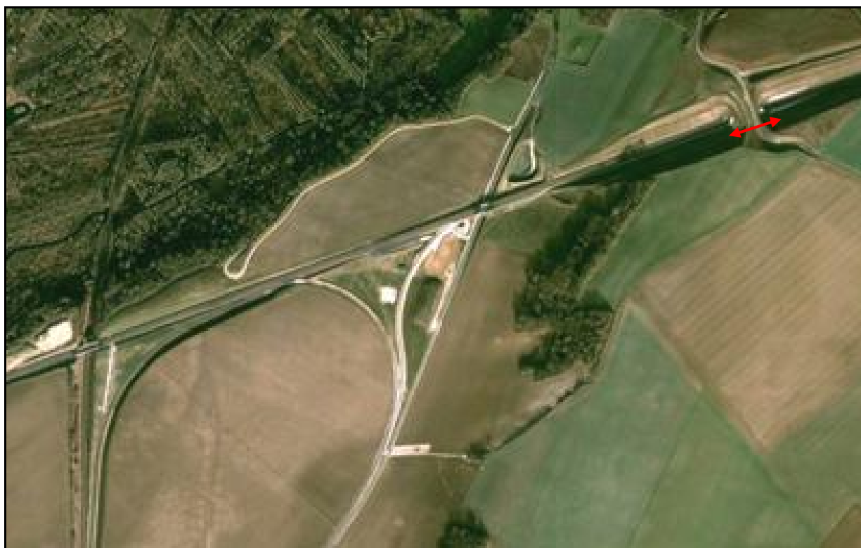
Vue aérienne du faux tunnel d'Ocquerre
