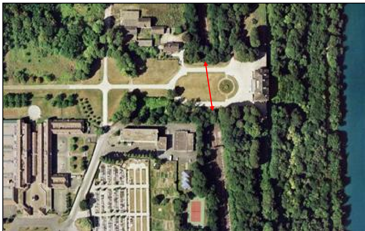
Vue aérienne de la galerie de la Rochette qui montre bien comment la voie ferrée coupait les terres du château
