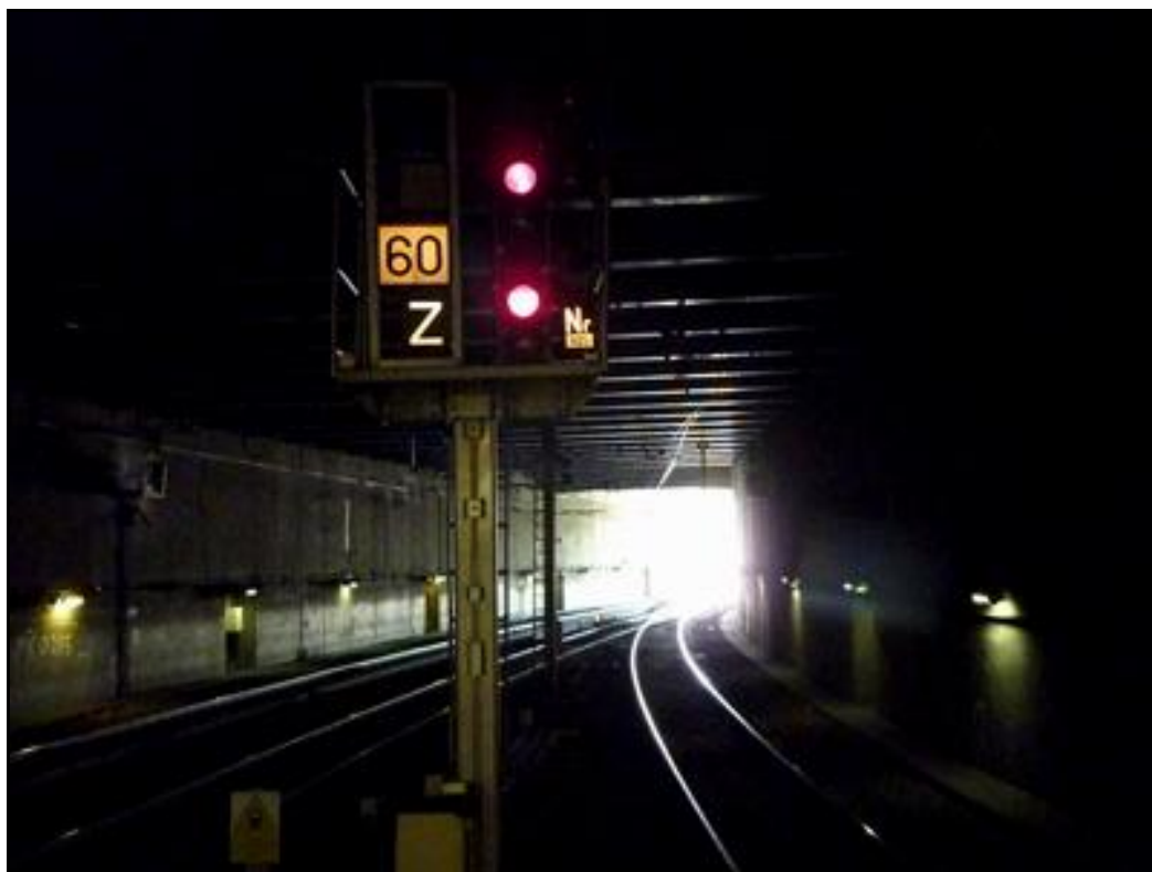
La galerie d'accès à la gare souterraine de Saint Germain
