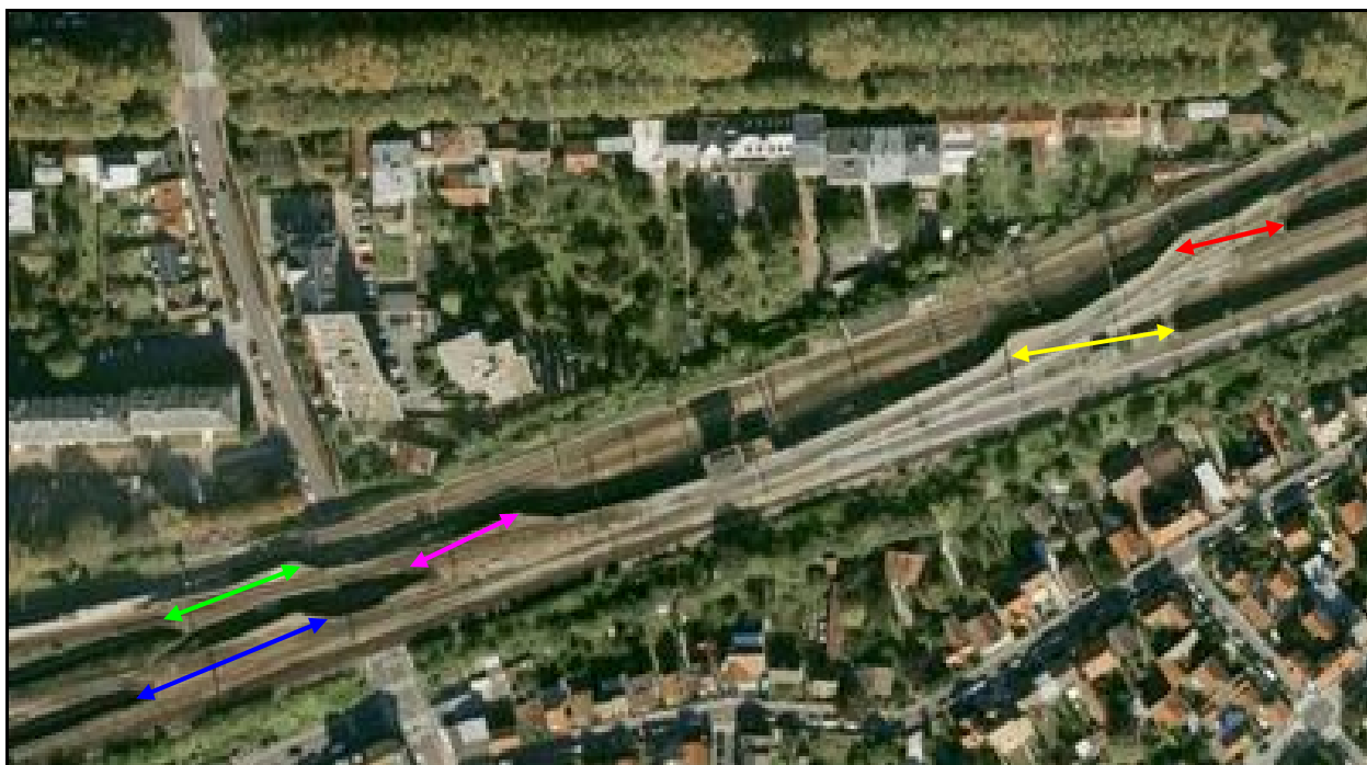
Vue aérienne de l'ensemble des sauts de mouton du nœud de Porchefontaine
