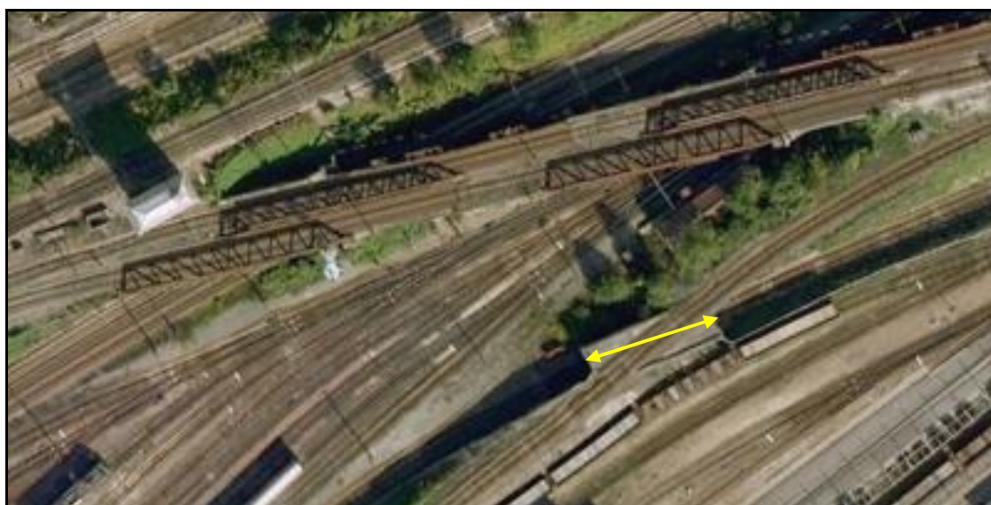
Vue aérienne du saut de mouton de la Canardière Ouest
