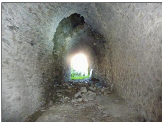
Gros décrochement de voûte avec une belle cloche d'effondrement La fracture du parement laisse apparaître la faiblesse de celui-ci
