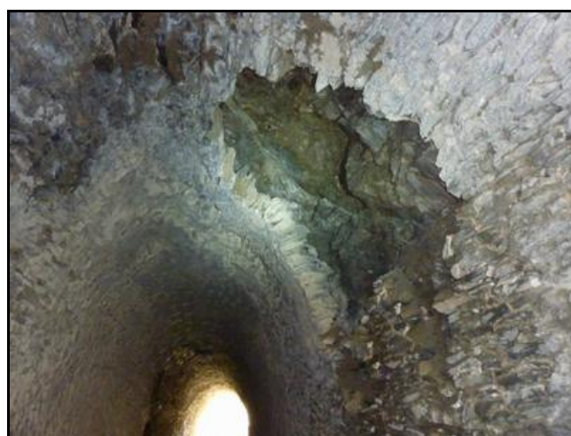
Gros décrochement de voûte avec une belle cloche d'effondrement La fracture du parement laisse apparaître la faiblesse de celui-ci
