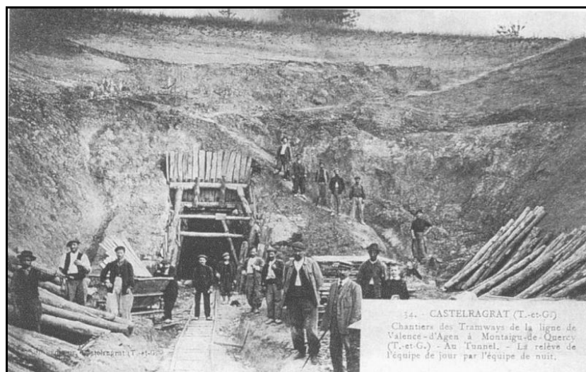
Ci-dessus et ci-dessous, autres photos de l'entrée de la galerie avec les ouvriers du chantier
