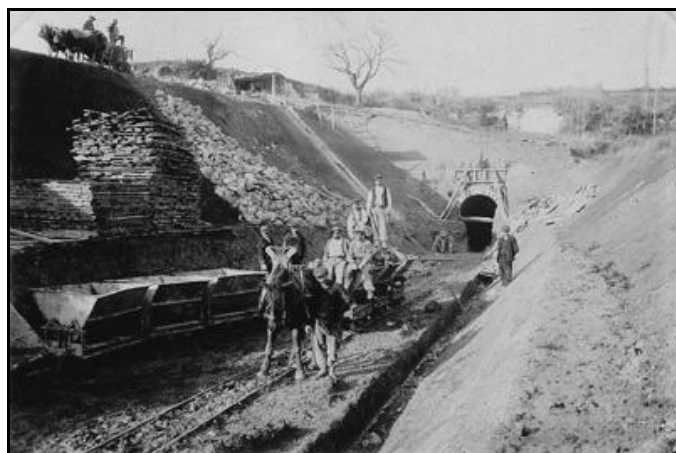
La mise en sécurité de la voûte vient d'être effectuée par construction de sa maçonnerie Le radier (sol du tunnel) va être maintenant abaissé
