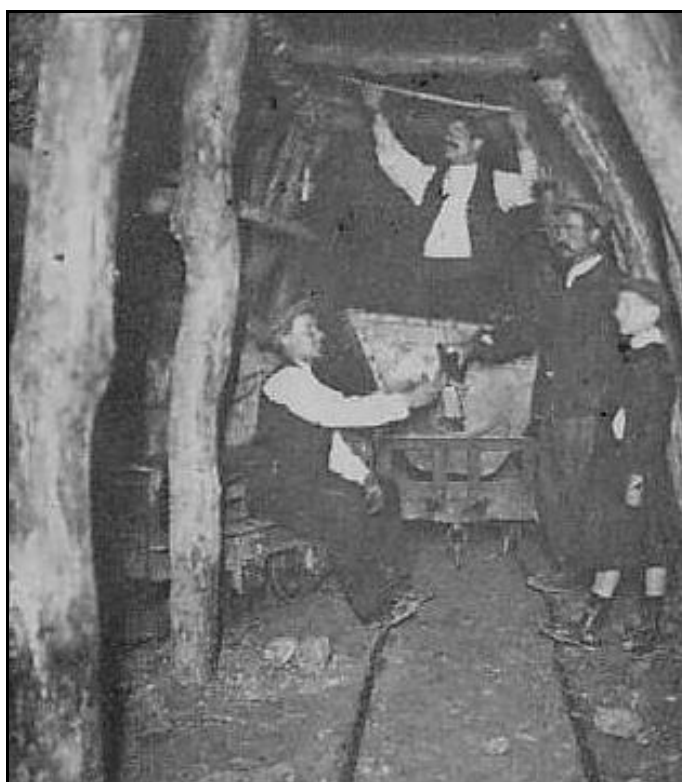
Le front de taille et le boisage de la galerie Noter la présence du jeune garçon, ce qui n'était pas rare sur les chantiers de l'époque
