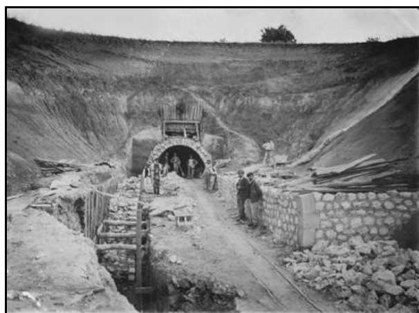
La mise en sécurité de la voûte vient d'être effectuée par construction de sa maçonnerie Le radier (sol du tunnel) va être maintenant abaissé
