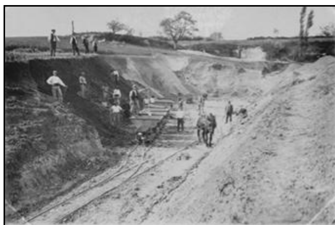
Amorce de la galerie d'axe côté entrée alors que la tranchée de sortie est en cours de finition
