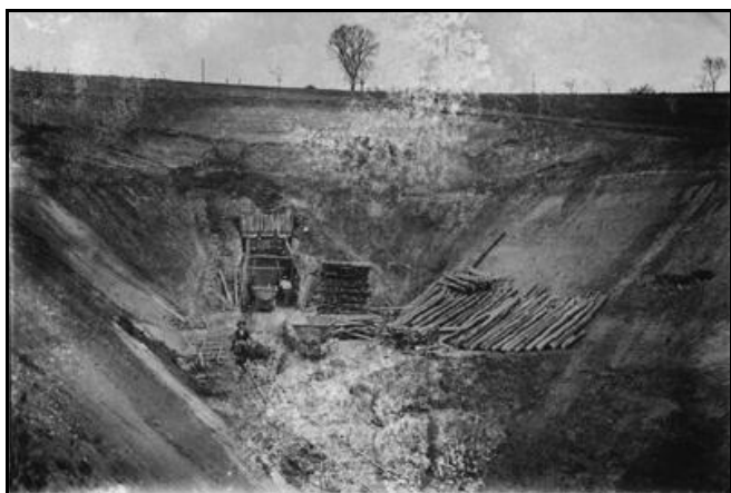
Amorce de la galerie d'axe côté entrée alors que la tranchée de sortie est en cours de finition
