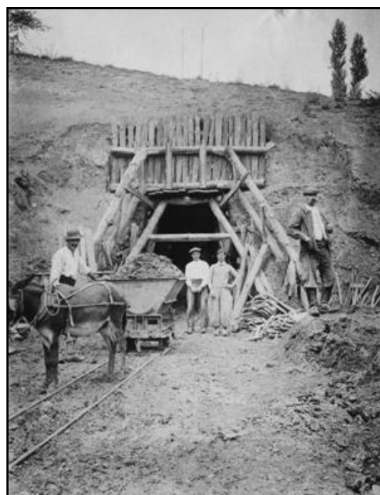
La galerie d'axe est maintenant entamée des deux côtés et d'importantes réserves de bois sont nécessaires à son boisage
