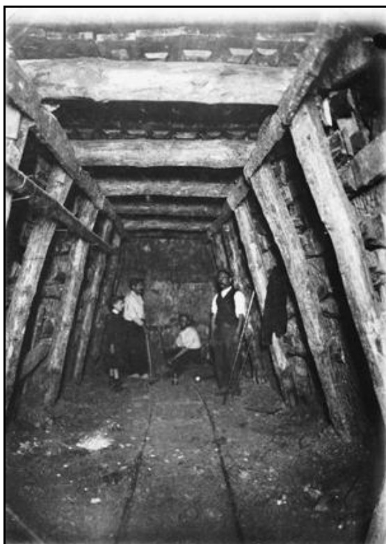
Le front de taille et le boisage de la galerie Noter la présence du jeune garçon, ce qui n'était pas rare sur les chantiers de l'époque
