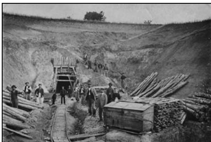
La galerie d'axe est maintenant entamée des deux côtés et d'importantes réserves de bois sont nécessaires à son boisage
