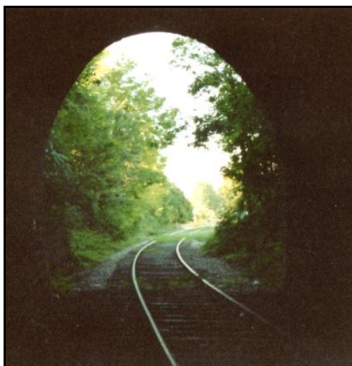
L'entrée du tunnel vue de l'intérieur
