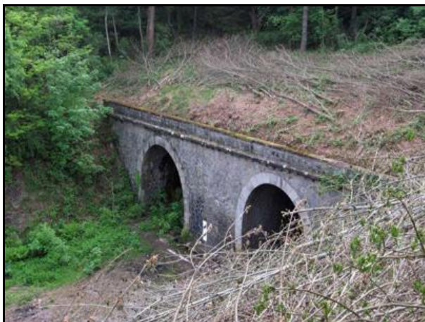
L'entrée du tunnel est ici au second plan
