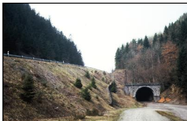
La sortie du tunnel abandonné dans son état actuel
