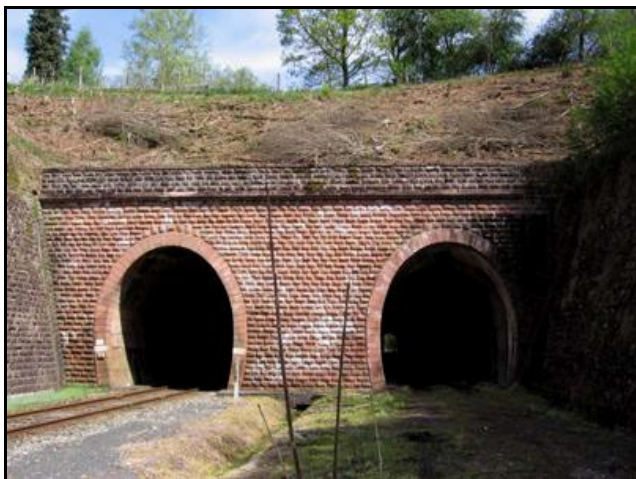
L'entrée du tunnel est ici à gauche
