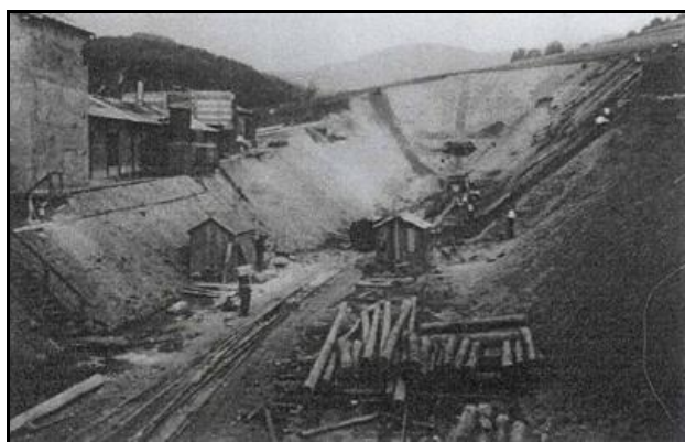
Fouille préparatoire à l'entrée du tunnel
