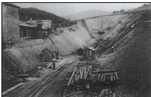
Fouille préparatoire à l'entrée du tunnel
