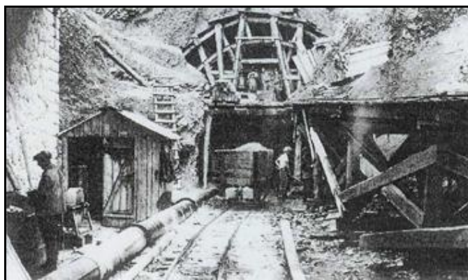
La sortie du tunnel lors de la construction
