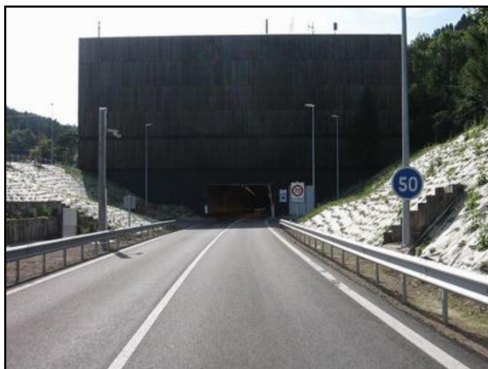
L'entrée et la sortie du tunnel aujourd'hui Les bâtiments sont les usines d'aération du souterrain
