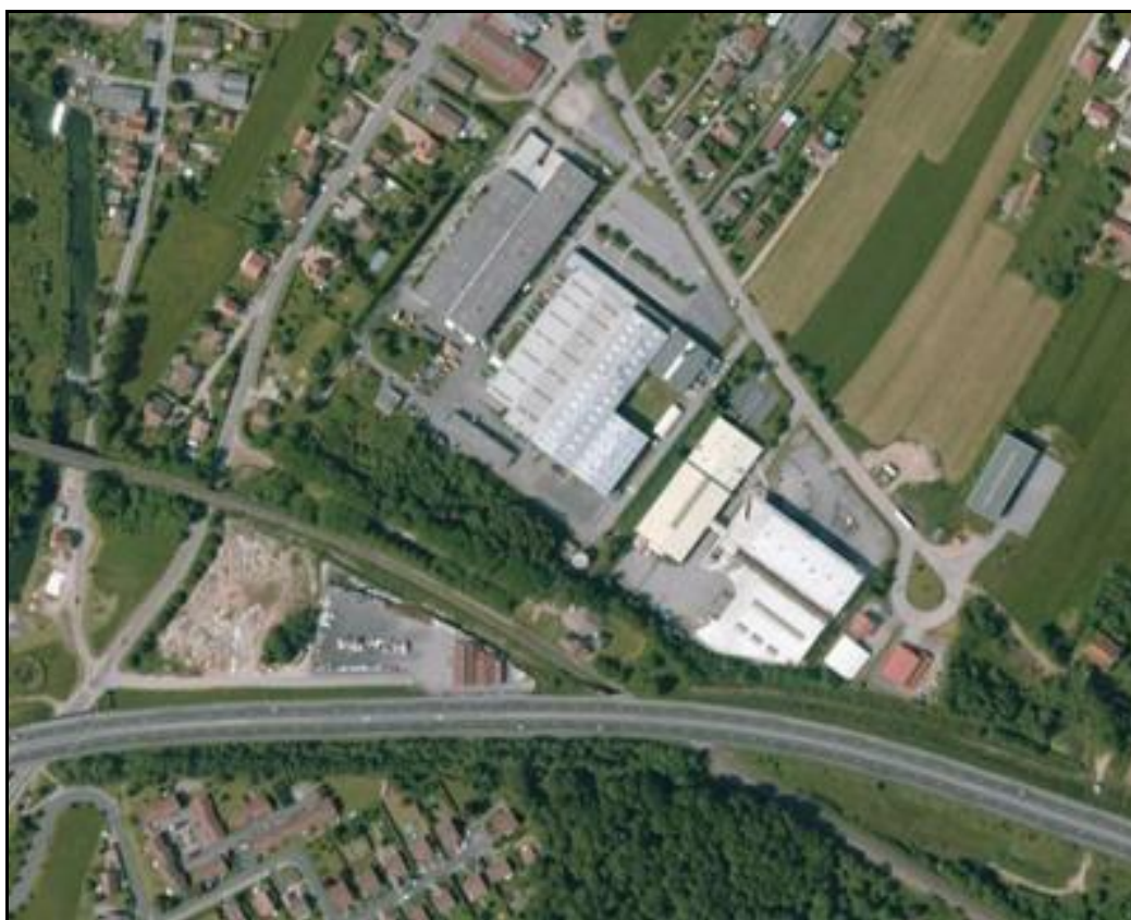
Vue aérienne de la galerie sous la route
