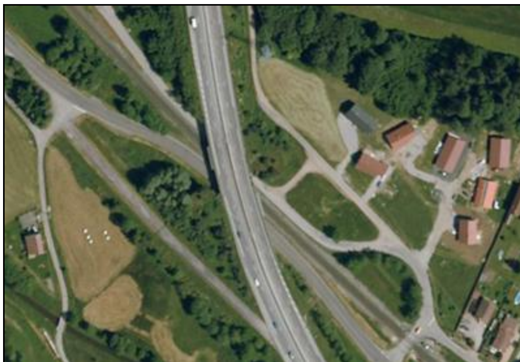
Vue aérienne de la galerie sous la route
