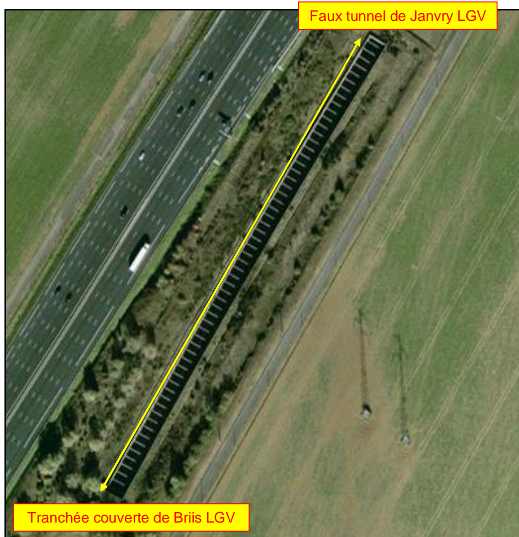
Détail de la tranchée en encoffrement
