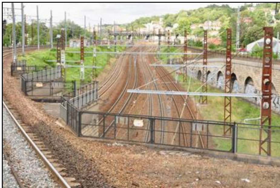
Vue de l'entrée des galeries prise de la ligne supérieure A droite, la rampe d'accès au saut de mouton de l'île Brune 2
