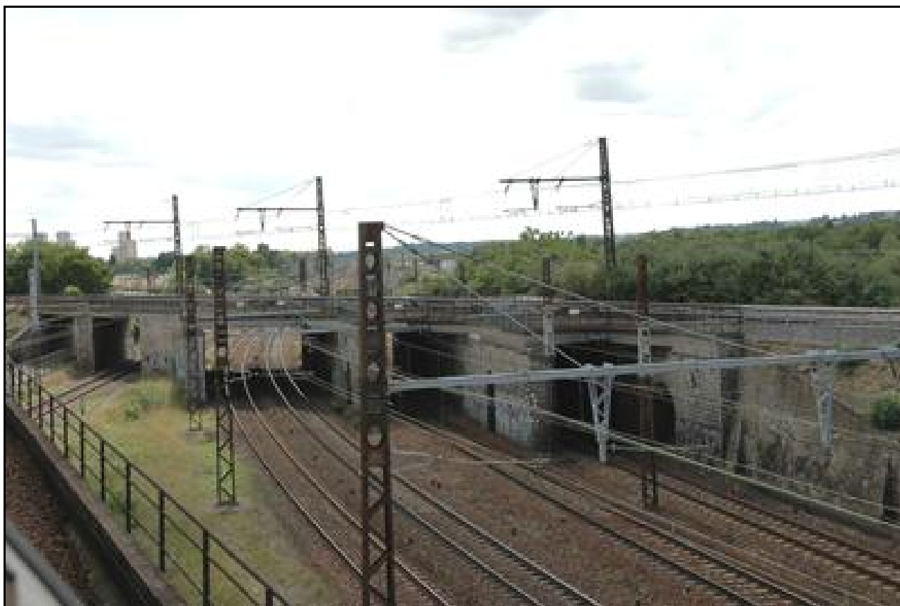
L'entrée du saut de mouton de l'Ile Brune 1 avec ses 4 galeries
