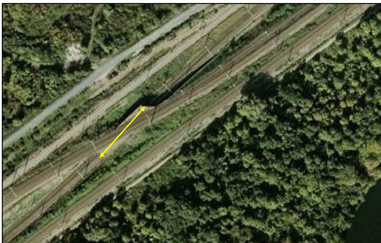
Vue aérienne du saut de mouton de Montalbot
