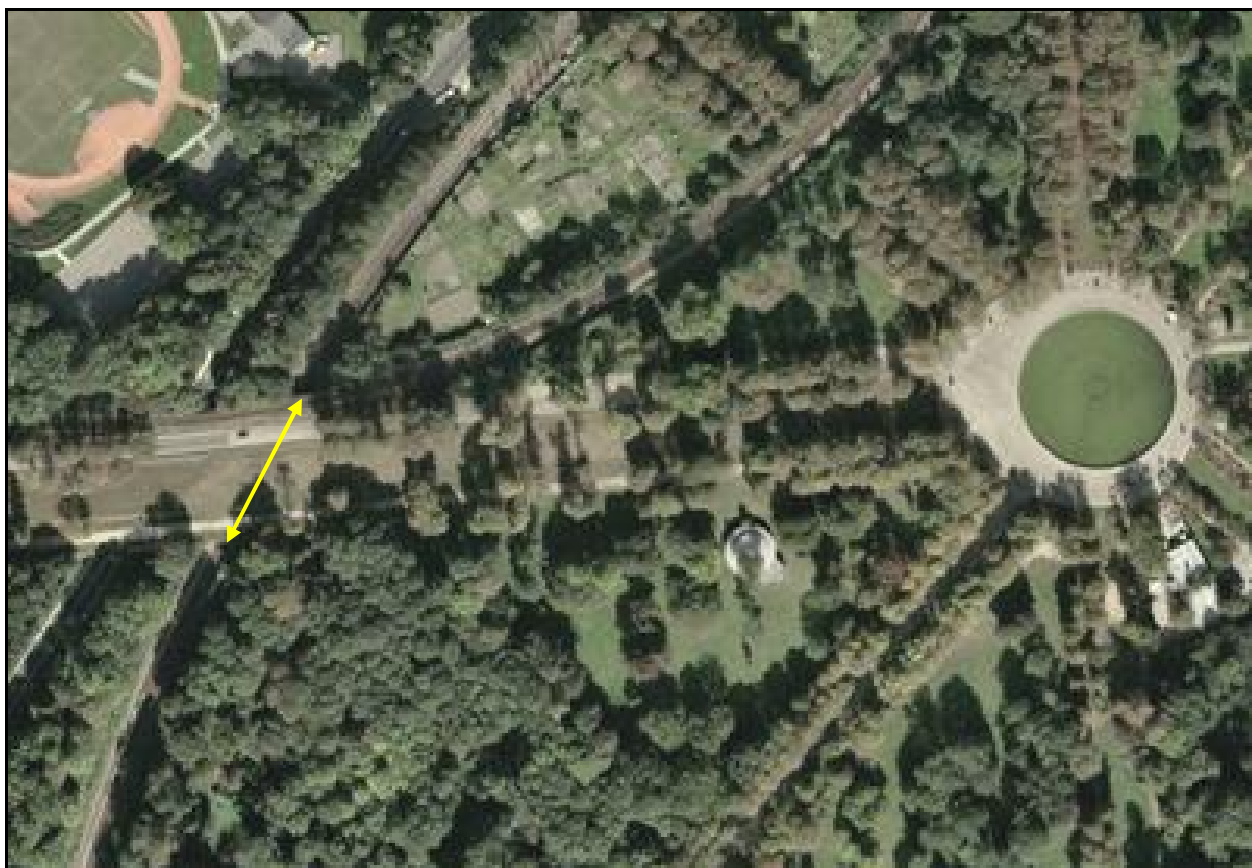
Vue aérienne de la galerie de Pré Saint Jean Nord
