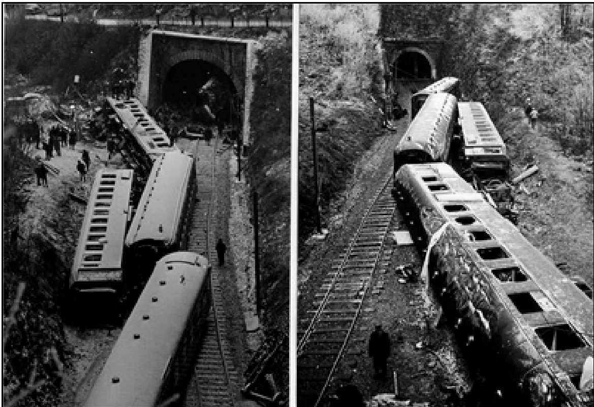
La queue du train déraillé entre les tunnels des Ecomboles 2 (à gauche) et du Cul de Brey 1 (à droite)
