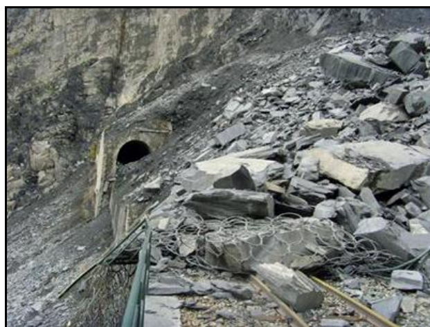
La galerie de protection de la sortie du tunnel de Serguignou Avant et après l'éboulement par lequel elle a été totalement emportée
