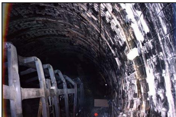
Ci-dessus et ci-dessous, les dégâts sur une locomotive, les camions, les wagons et la voûte
