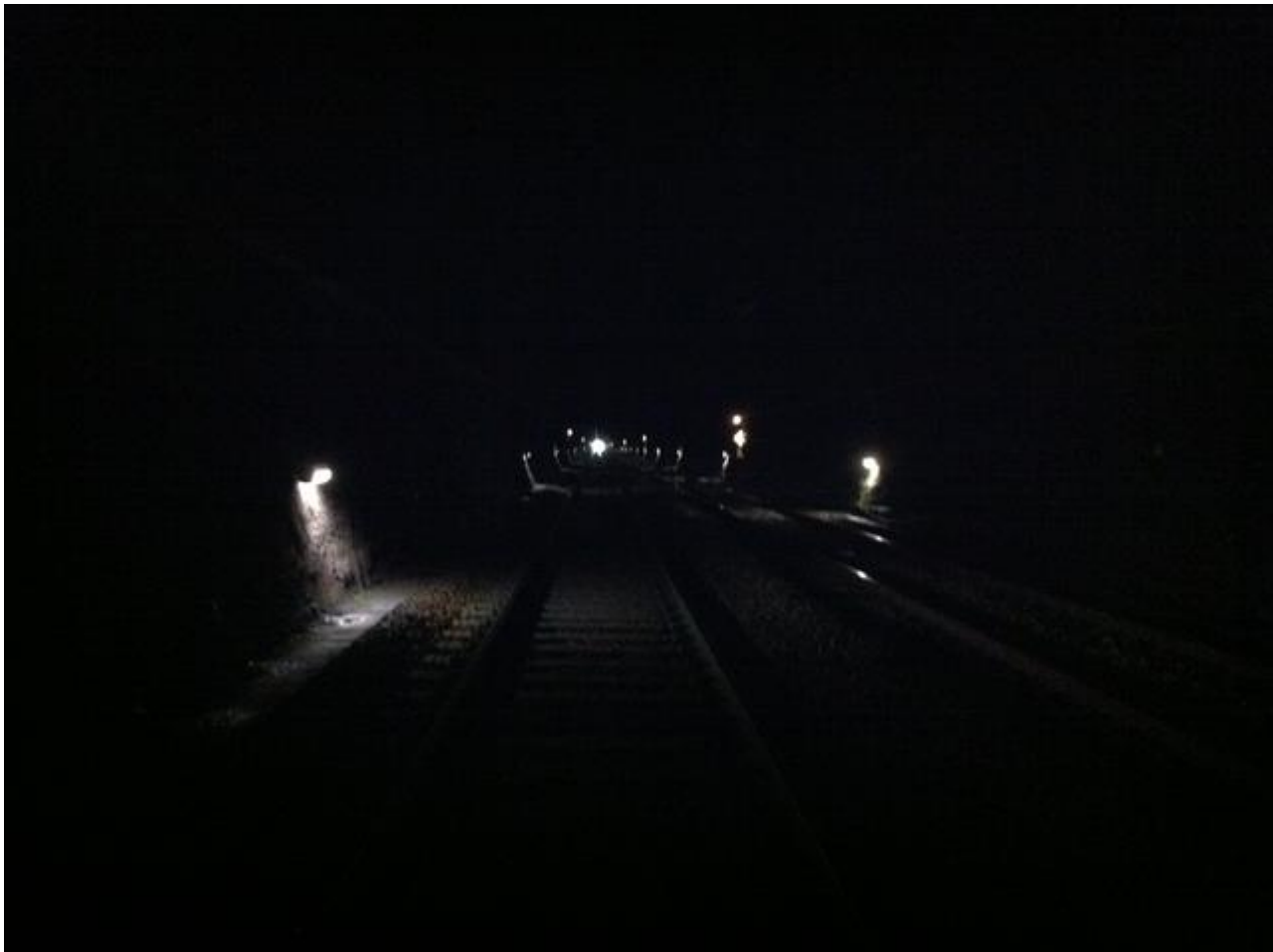
L'intérieur du tunnel vu en direction de la sortie (04/04/2011)
