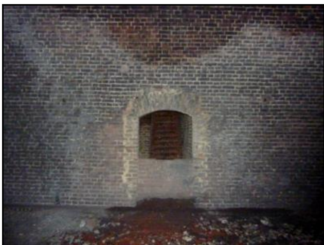
Accès aux chambres de dynamitage latérales gauches et droites
