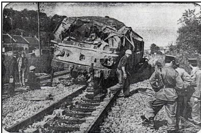
Ci-dessus et ci-dessous, l'état du matériel après extraction du tunnel montre bien la violence du choc
