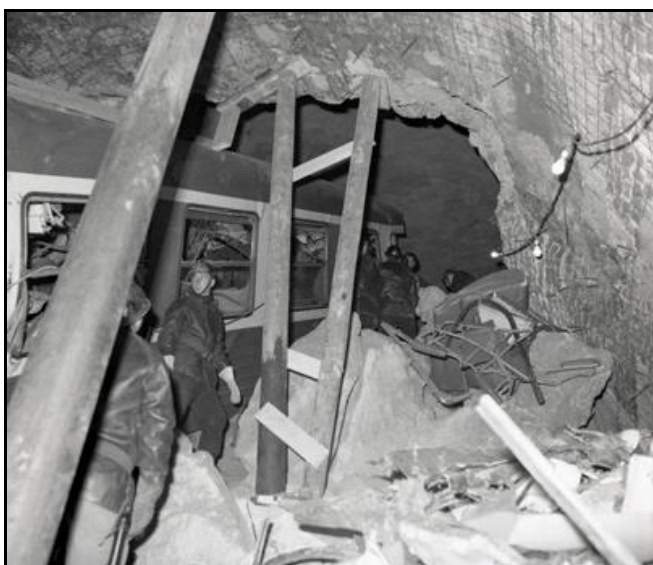
Ci-dessus et ci-dessous : Très vite apparaît la nécessité d'étayer la voûte pour éviter un nouvel effondrement
