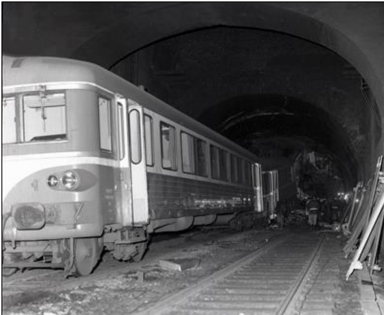
Vue générale du lieu de l'accident Au premier plan, au-dessus de l'autorail, la cloche résultant du dynamitage de la première guerre mondiale Au fond, l'effondrement et le train encastré dans la voûte
