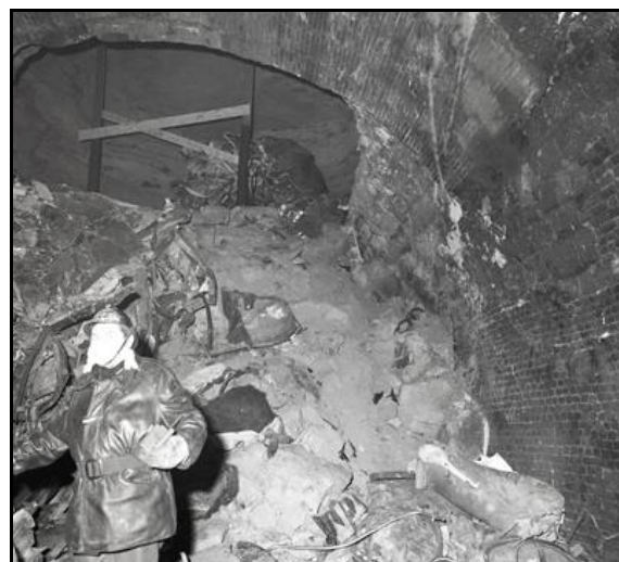
Ces deux photos montrent l'exacte dimension du chaos et de la cloche d'effondrement
