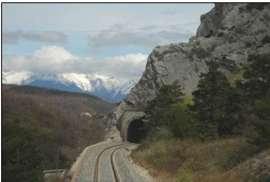
Le tunnel de Fontaine dans son magnifique cadre
