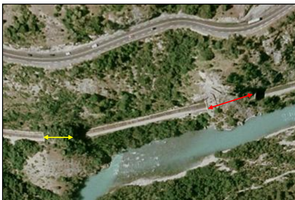
Vue aérienne des tunnels de Gorsas (à gauche) et de Serre de Buis (à droite) le long de la Durance
