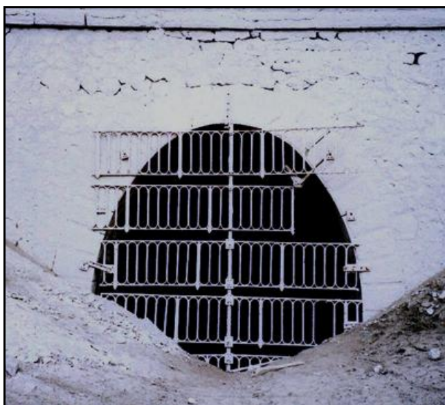
Noter que le tunnel a été fermé avec des rambardes de viaduc récupérées
