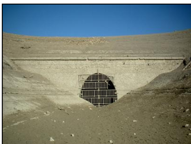
Noter que le tunnel a été fermé avec des rambardes de viaduc récupérées
