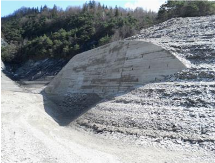
Soutènement supérieur visible sur la photographie précédente
