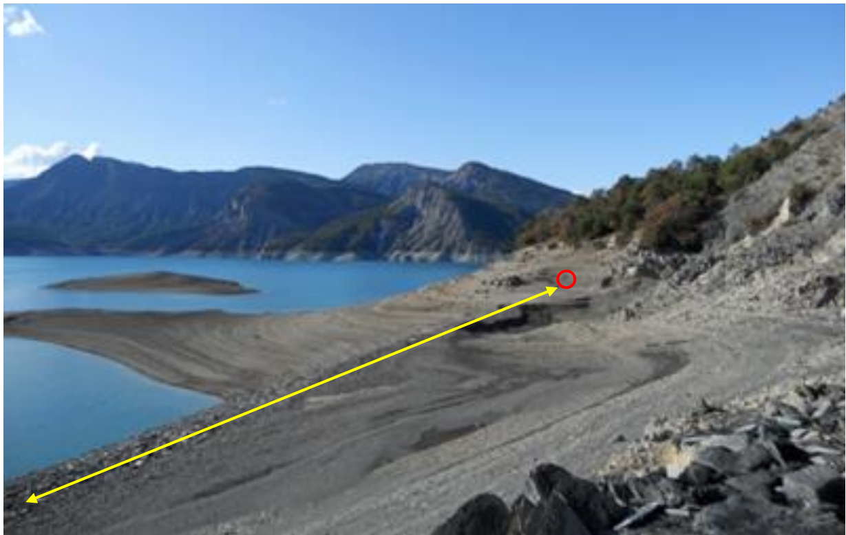
Le tracé de l'ancienne voie ferrée et l'emplacement de la sortie du tunnel
